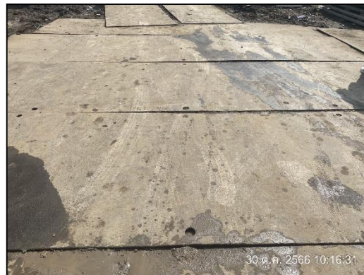
ภาพที่ 22 ปูแผ่นเหล็กอย่างหนาไว้บริเวณพื้นที่ก่อสร้าง
