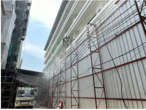
รูปที่ 13 ระบบสเปรย์น้ำลดฝุ่น
