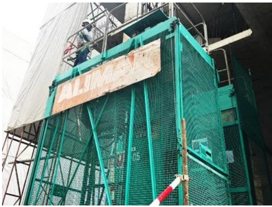
รูปที่ 53 ลิฟต์ขนส่งของของโครงการ
