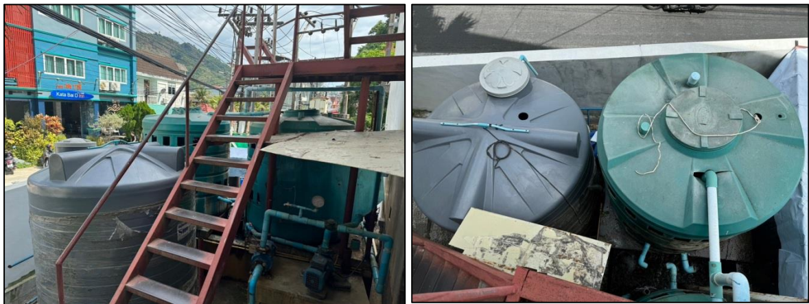
รูปที่ 3-15 ถังเก็บน้ำใช้สำรอง
