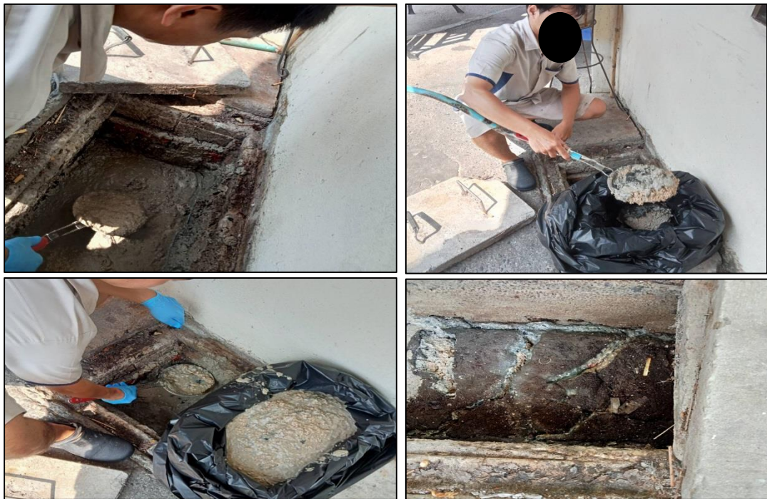
รูปที่ 3-6 เจ้าหน้าที่ตัดไขมัน และทำความสะอาดบ่อตัดไขมัน
