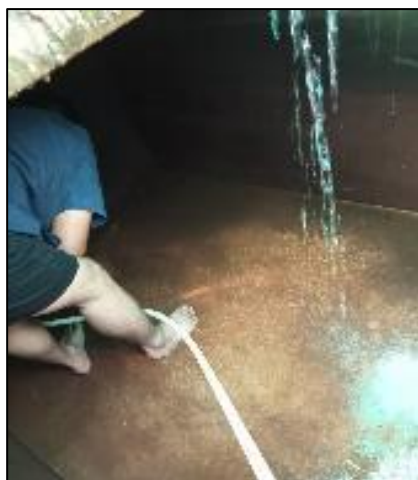
รูปที่ 3-3 การล้างทำความสะอาดถังน้ำใช้
