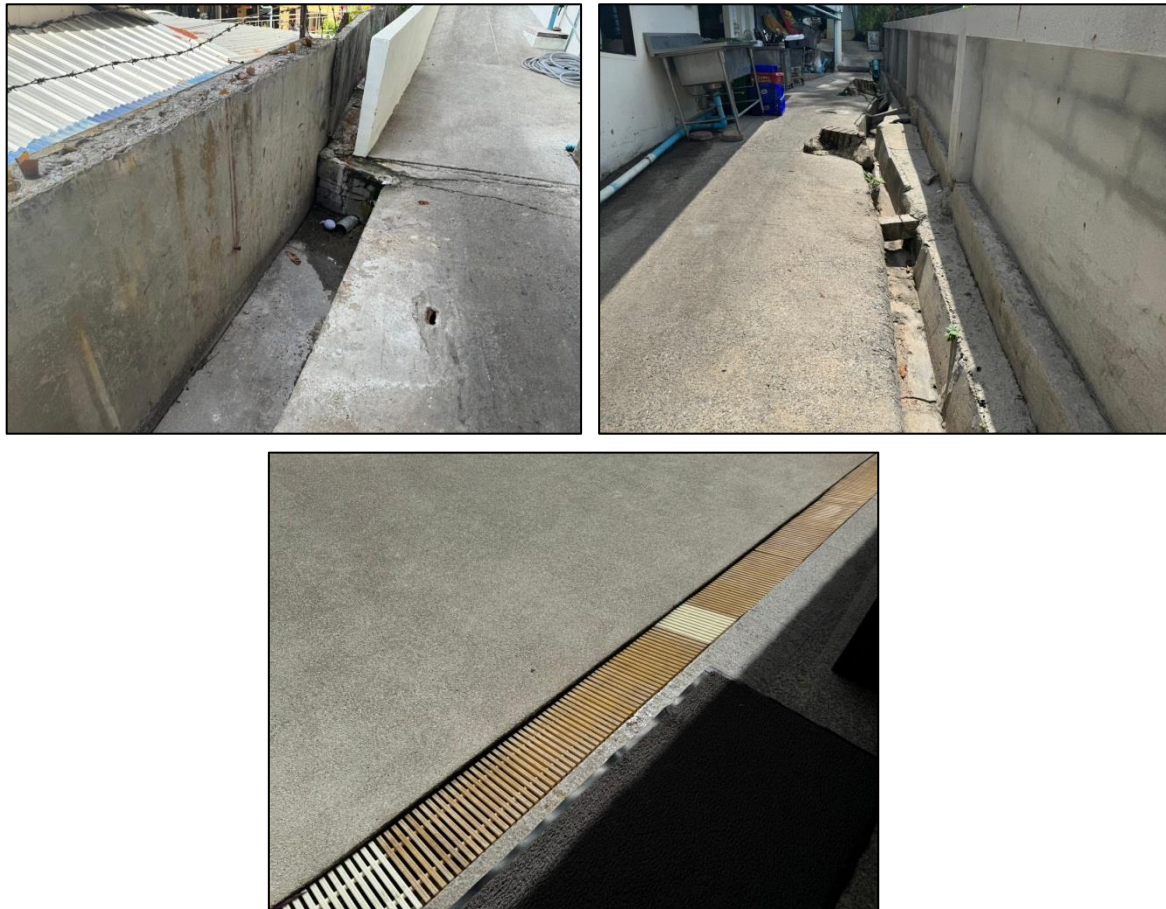
รูปที่ 3-19 ท่อระบายน้ำและตะแกรงดักขยะบริเวณท่อระบายน้ำภายในโครงการ
