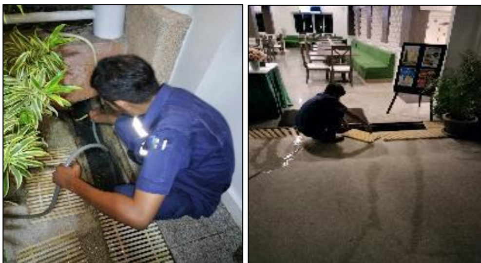
รูปที่ 3-20 เจ้าหน้าที่ชุดลอกและทำความสะอาดท่อระบายน้ำ
