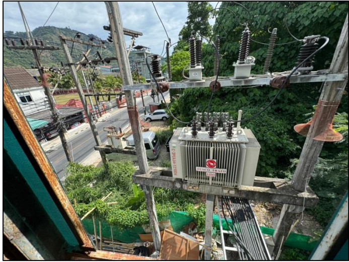
รูปที่ 3-11 หม้อแปลงไฟฟ้าของโครงการ
