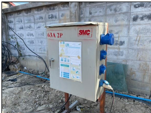
รูปที่ 24 แผงควบคุมไฟฟ้า และเครื่องตัดกระแสไฟฟ้าอัตโนมัติ
