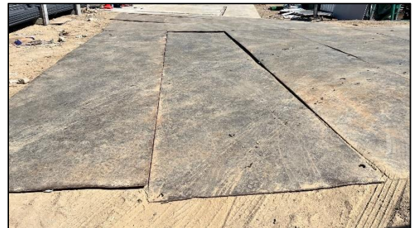
รูปที่ 7 แผ่นเหล็กอย่างหนาปูให้ทั่วบริเวณภายในพื้นที่โครงการ
