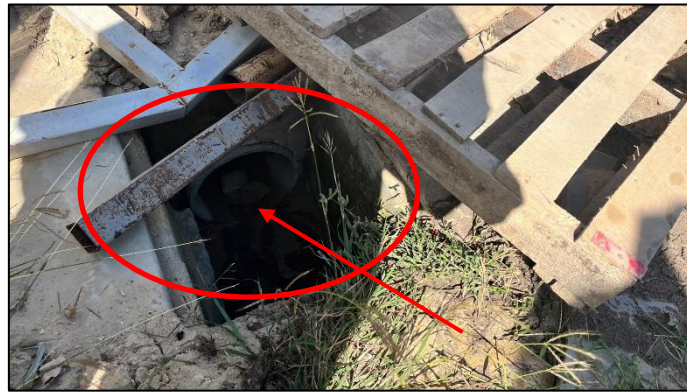
รูปที่ 11 ท่อระบายน้ำแบบรางปิดชั่วคราว
