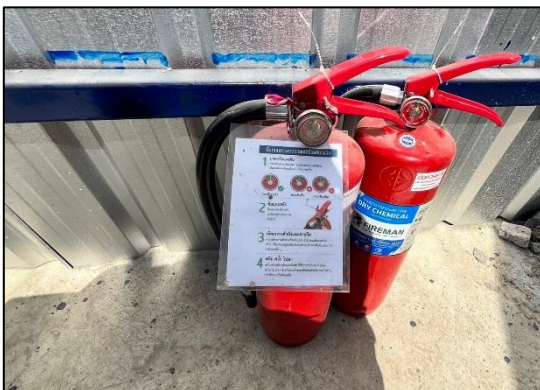
รูปที่ 19 อุปกรณ์ดับเพลิงเคมีประจำในพื้นที่ก่อสร้าง
