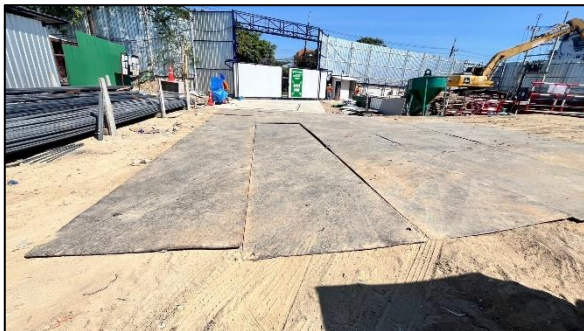
รูปที่ 7 แผ่นเหล็กอย่างหนาปูให้ทั่วบริเวณภายในพื้นที่โครงการ
