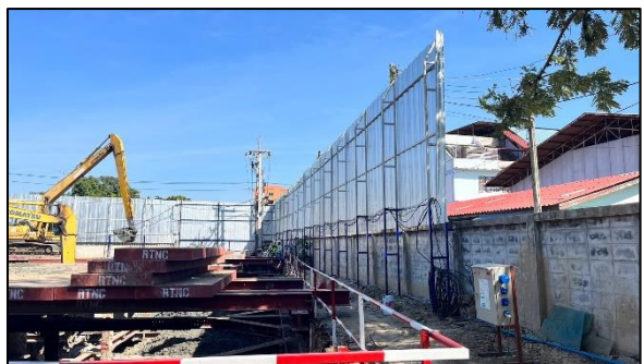
รูปที่ 1 รั้ว Metal Sheet (แผ่นเหล็กกริดลอน) บริเวณโดยรอบพื้นที่ก่อสร้าง
