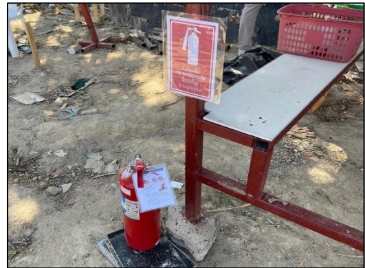
รูปที่ 19 (ต่อ) อุปกรณ์ดับเพลิงเคมีประจำในพื้นที่ก่อสร้าง
