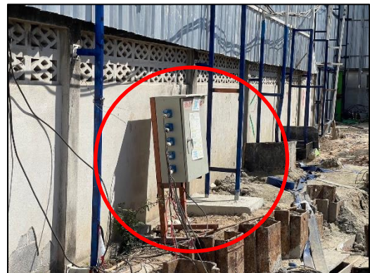
รูปที่ 24 แผงควบคุมไฟฟ้า และเครื่องตัดกระแสไฟฟ้าอัตโนมัติ
