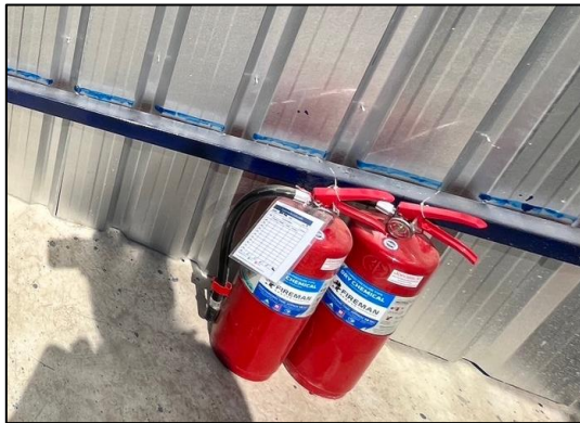
รูปที่ 19 (ต่อ) อุปกรณ์ดับเพลิงเคมีประจำในพื้นที่ก่อสร้าง
