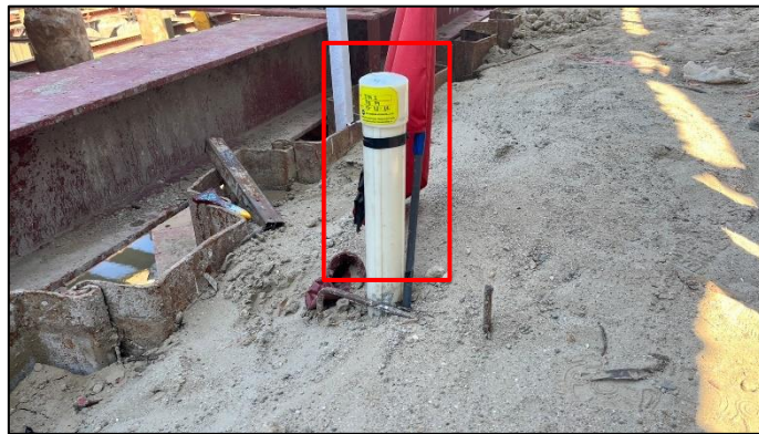
รูปที่ 9 การติดตั้งเครื่องมือตรวจวัดการเคลื่อนตัวของดิน (Inclinometer) กับแนวกำแพงดิน Pile Wall
