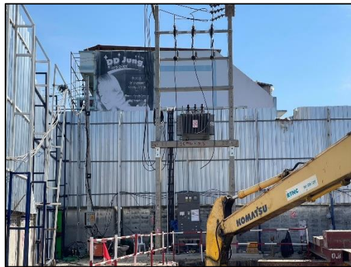
รูปที่ 23 หม้อแปลงไฟฟ้าในพื้นที่ก่อสร้าง
