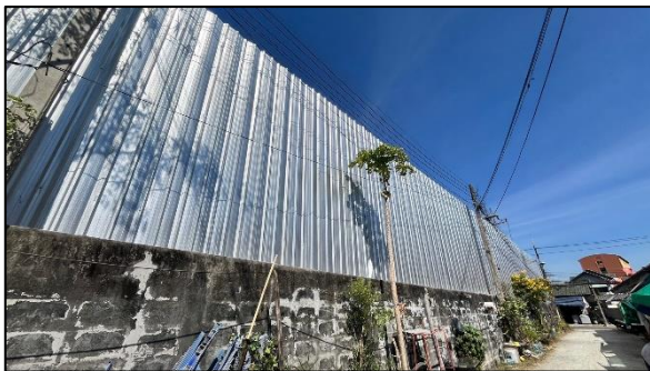
รูปที่ 1 รั้ว Metal Sheet (แผ่นเหล็กกริดลอน) บริเวณโดยรอบพื้นที่ก่อสร้าง
