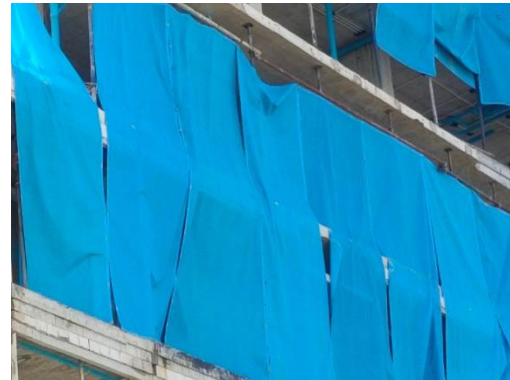
รูปที่ 3-8 ผ้าใบกันป้องกันฝุ่น (Mesh sheet)
