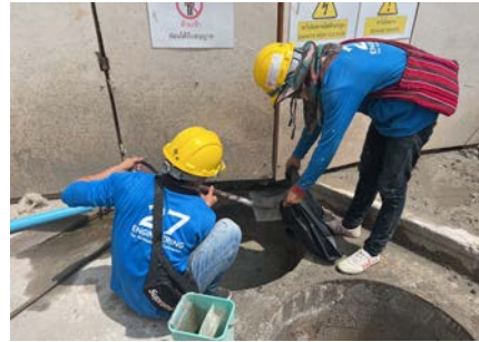
รูปที่ 14 คนงานทำความสะอาดบ่อดักขยะ
