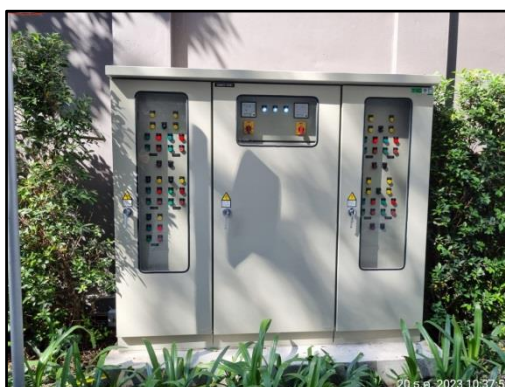
รูปที่ 1-8 ระบบมิเตอร์ไฟฟ้าสำหรับระบบบำบัดน้ำเสียของโครงการ
