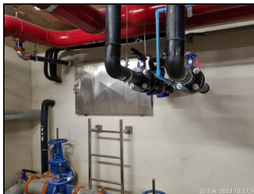
รูปที่ 1-6 ถังเก็บน้ำดับเพลิงใต้ดิน
