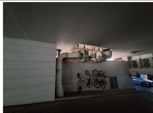
รูปที่ 52 พัดลมระบายอากาศ
