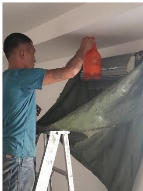
รูปที่ 14 ทำความสะอาดเครื่องปรับอากาศ
