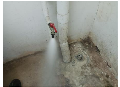
ก๊อกน้ำ และท่อระบายน้ำในห้องพักขยะ
