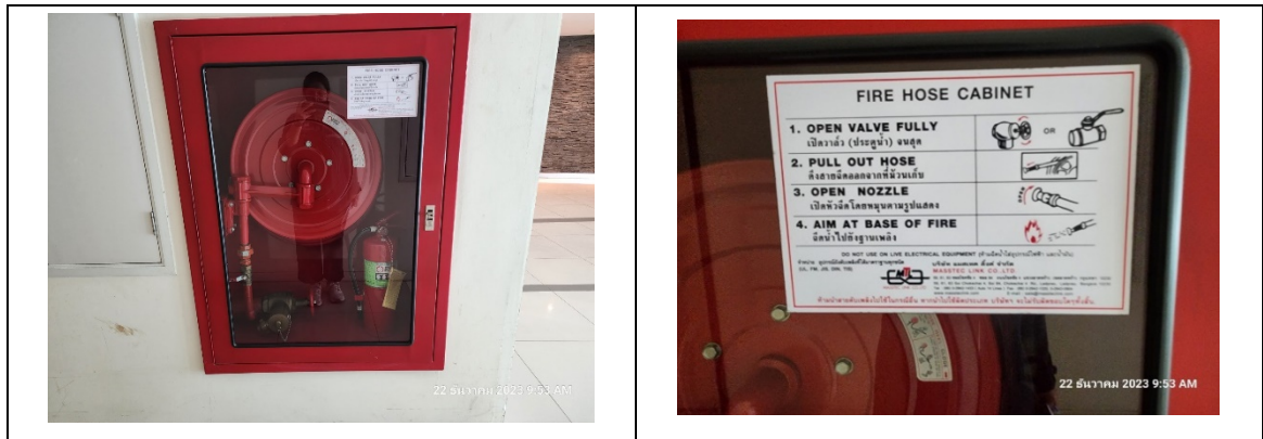
รูปที่ 29 ตู้ดับเพลิงพร้อมวิธีใช้
