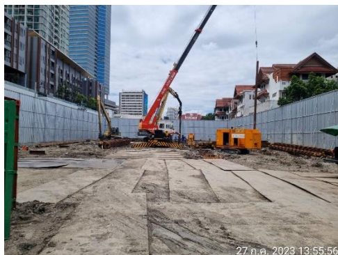
รูปที่ 20 ปูแผ่นเหล็ก
