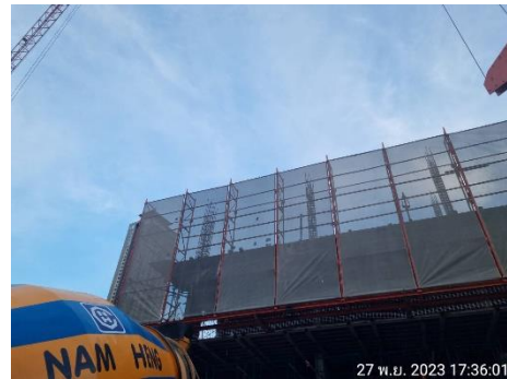
รูปที่ 40 ติดตั้งผ้าใบก่อสร้างMesh sheet
