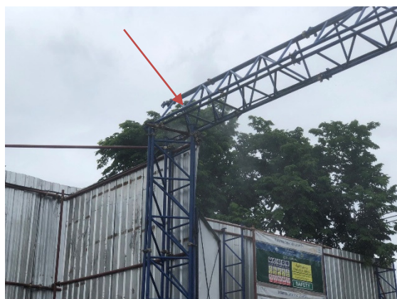
ภาพที่ 36 สเปรย์น้ำละอองฝอยที่แนวรั้ว
