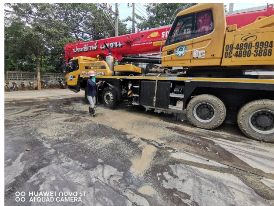
ภาพที่ 13 จุดล้างล้อรถบริเวณทางเข้า-ออกพื้นที่โครงการ
