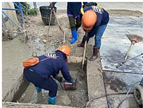
ภาพที่ 18 การสะอาดบ่อดักตะกอนดิน
