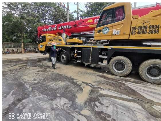
ภาพที่ 9 จุดล้างทำความสะอาดล้อรถ
