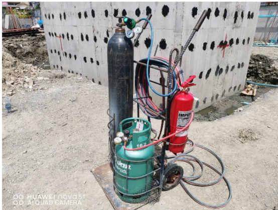
ภาพที่ 23 การติดตั้งถังดับเพลิงในพื้นที่ก่อสร้าง
