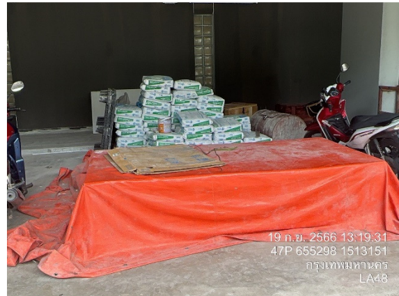
ภาพที่ 25 ปิดคลุมวัสดุก่อสร้างด้วยผ้าคลุมมิดชิด
