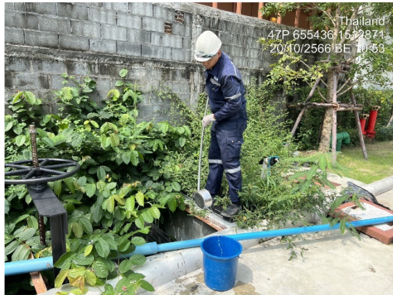
ภาพที่ 24 บ่อดักขยะก่อนระบายน้ำออกจากโครงการ
