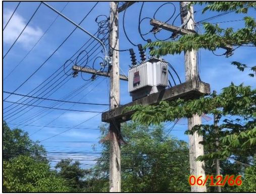
รูปที่ 2.2-7 หม้อแปลงไฟฟ้าภายในโครงการ
