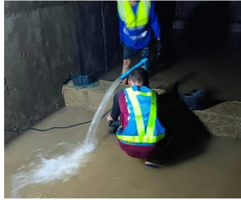
รูปที่ 50 การทำความสะอาดถึงน้ำใช้ชั้นดาดฟ้า
