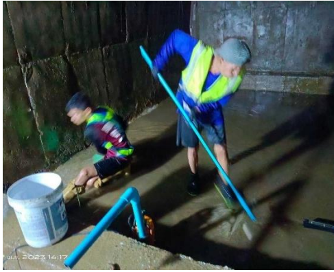
รูปที่ 50 การทำความสะอาดถึงน้ำใช้ชั้นดาดฟ้า
