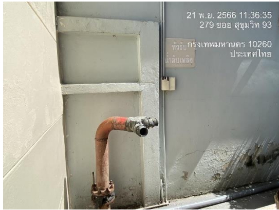
รูปที่ 26 หัวรับน้ำดับเพลิง (Siamese Connection)
