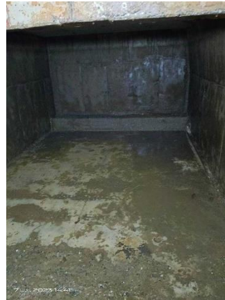
รูปที่ 50 การทำความสะอาดถึงน้ำใช้ชั้นดาดฟ้า
