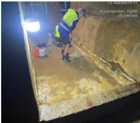
รูปที่ 50 การทำความสะอาดถึงน้ำใช้ชั้นดาดฟ้า
