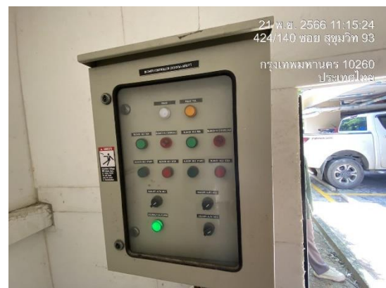
รูปที่ 6 ระบบมิเตอร์ไฟฟ้าสำหรับระบบบำบัดน้ำเสีย ของโครงการโดยเฉพาะแยกจากระบบไฟฟ้าอื่นๆ
