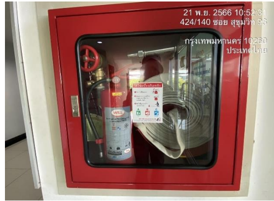
รูปที่ 27 ตู้เก็บสายฉีดน้ำดับเพลิงพร้อมอุปกรณ์ (Fire Hose Cabinet : FHC)
