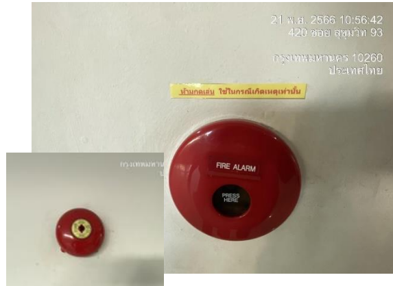
รูปที่ 33 กริ่งสัญญาณเตือนภัย (Alarm Bell) และเครื่องแจ้งเหตุโดยใช้มือดึง (Fire Alarm Manual Station)
