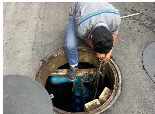
รูปที่ 41 การตักขยะ ตะกอนออกจากท่อระบายน้ำเพื่อป้องกันน้ำท่วม
