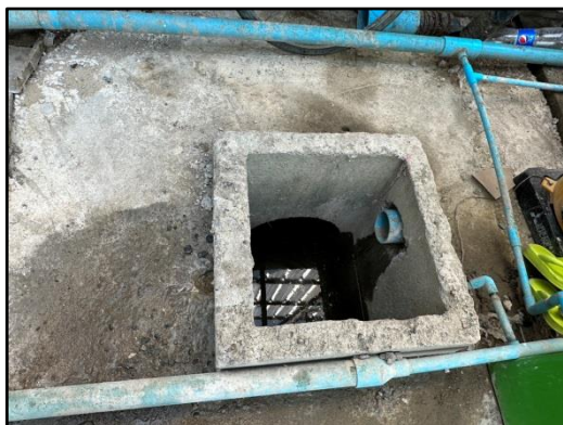
รูปที่ 30 รายละเอียดน้ำและท่อระบายน้ำชั่วคราวของโครงการ
