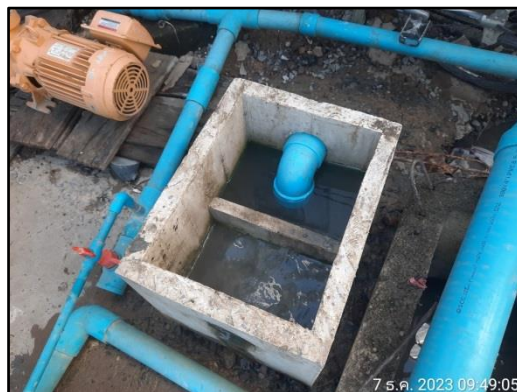
รูปที่ 30 รายละเอียดน้ำและท่อระบายน้ำชั่วคราวของโครงการ
