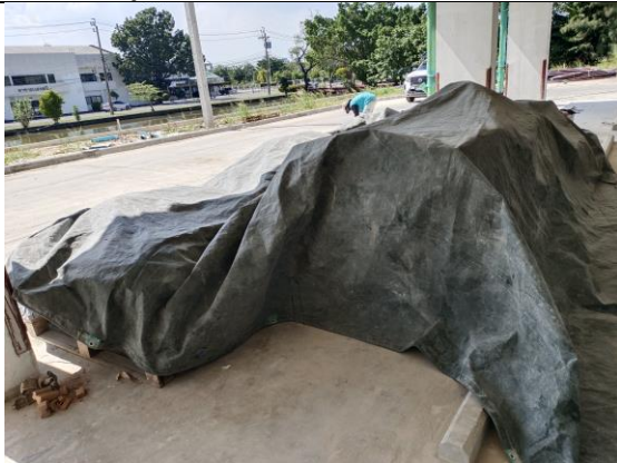
รูปที่ 9 ผ้าใบคลุมกองวัสดุก่อสร้าง
