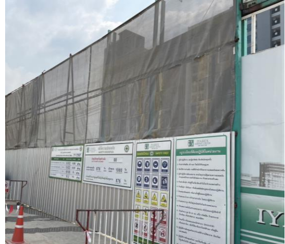
รูปที่ 2 รั้ว Mesh Sheet กันฝุ่น
