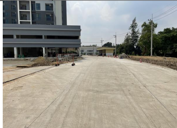
รูปที่ 30 คอนกรีตปูบริเวณทางเข้า-ออก ที่ก่อสร้างเรียบร้อยแล้ว
