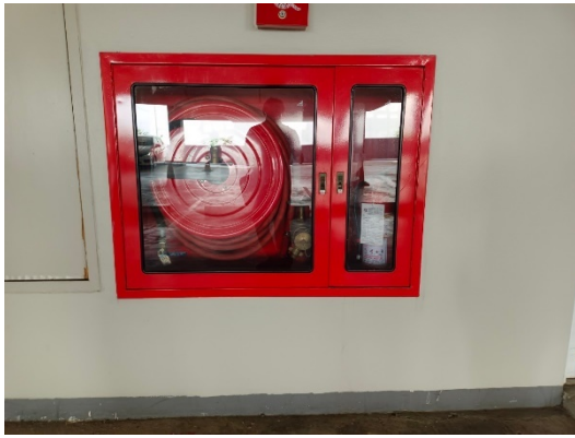
รูปที่ 19 ตู้เก็บสายฉีดน้ำดับเพลิงพร้อมอุปกรณ์
