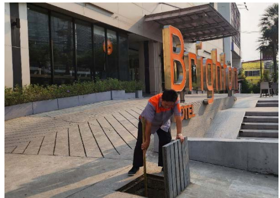
รูปที่ 22 ขุดลอกรางระบายน้ำภายในโครงการ
