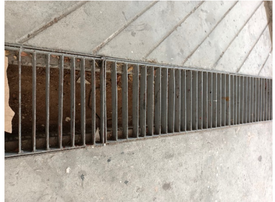
รูปที่ 8 ติดตั้งตะแกรงดักมูลฝอยบริเวณจุดระบายน้ำหน้าโครงการ
