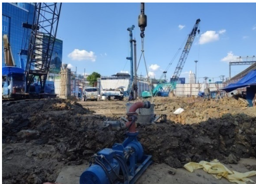
5-12 ทำเสาเข็มแบบเจาะ ชนิดเบี่ยง
