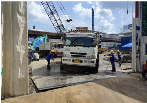
5-10 ล้างทำความสะอาดล้อรถบรรทุกก่อนออกสู่ภายนอกโครงการ
