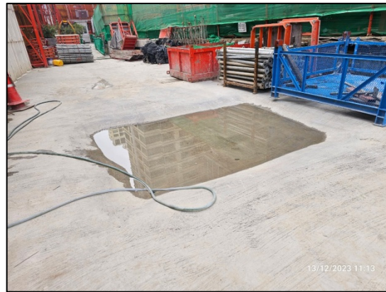
รูปที่ 11 พื้นที่ทำความสะอาดล้อรถบรรทุก และเจ้าหน้าที่ใช้น้ำฉีดล้างล้อก่อนออกจากโครงการ
