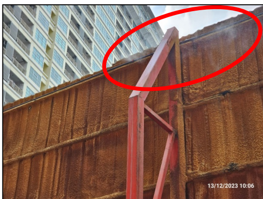
รูปที่ 15 ติดตั้งระบบแผ่นรองสปริงน้ำ บริเวณรั้ว Metal Sheet รอบโครงการ
