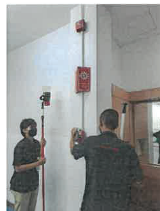
รูปที่ 3-54 การตรวจสอบระบบป้องกันและเตือนอัคคีภัย ให้สามารถใช้งานได้อยู่เสมอ
