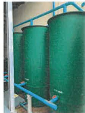
รูปที่ 3-16 ถังบำบัด Aerosol เพื่อบำบัดละอองน้ำ (Aerosol) จากระบบบำบัดน้ำเสีย
