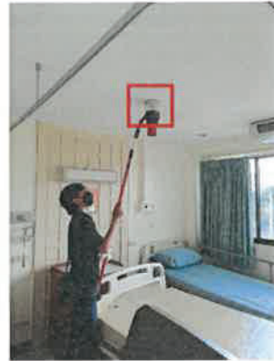
รูปที่ 3-26 เครื่องตรวจจับความร้อน (Heat Detector)
