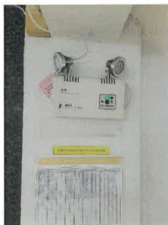
รูปที่ 3-29 ไฟส่องสว่างฉุกเฉิน
