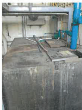
รูปที่ 3-15 ทำลายเชื้อโรคในน้ำทิ้ง โดยใช้วิธีเติมสารคลอรีน
