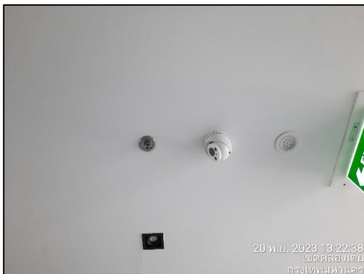
ภาพที่ 29 เครื่องตรวจจับความร้อนและควัน
