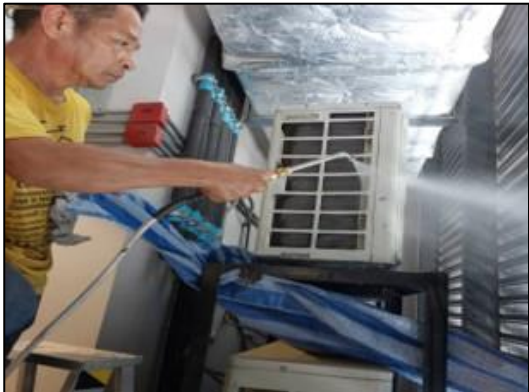
ภาพที่ 27 (ต่อ) ล้างแผ่นกรองอากาศและเครื่องปรับอากาศ
