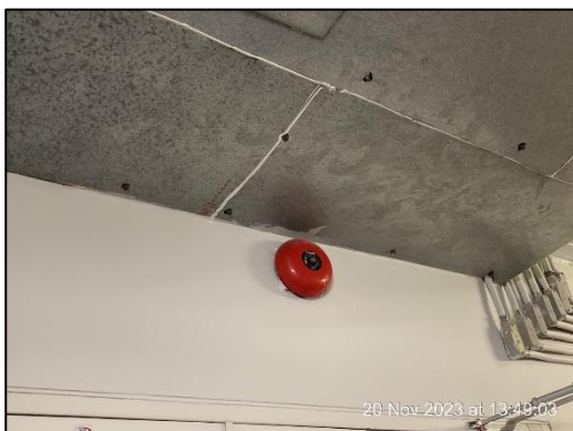
ภาพที่ 31 อุปกรณ์ส่งสัญญาณเตือนด้วยเสียง
