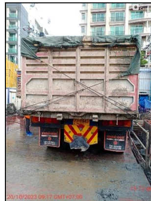
ภาพที่ 24 แผ่นสะท้อนแสงและธงสีบริเวณทำขุด
