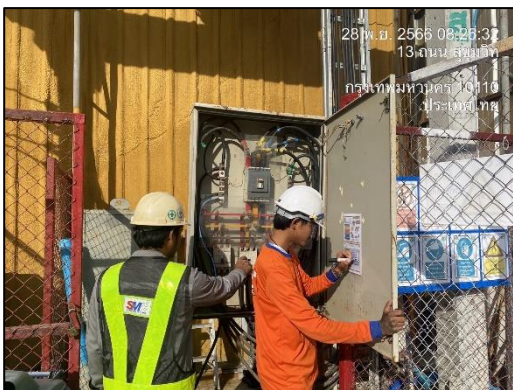
ภาพที่ 64 ตรวจสอบระบบสายไฟและอุปกรณ์ไฟฟ้า
