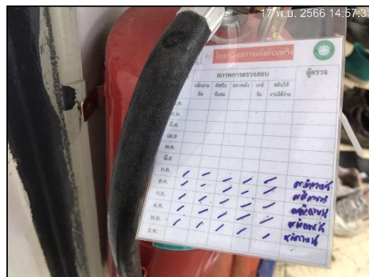
ภาพที่ 41 ตรวจสอบถังดับเพลิง
