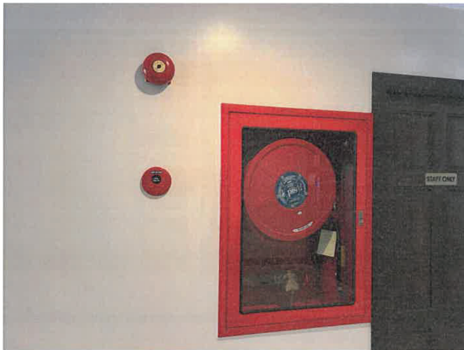
รูปที่ 3.2-34 ตู้เก็บอุปกรณ์ฯ FHC
