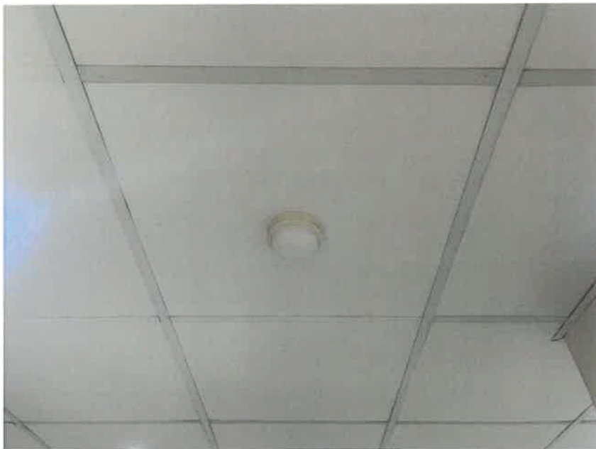
รูปที่ 3.2-37 เครื่องตรวจจับความร้อน (Heat Detector)
