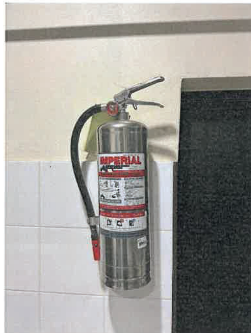
รูปที่ 3.2-35 ถังดับเพลิงเคมีชนิด A-B-C ขนาดความจุ 10 ปอนด์
