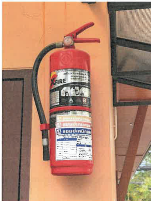
รูปที่ 3.2-35 ถังดับเพลิงเคมีชนิด A-B-C ขนาดความจุ 10 ปอนด์
