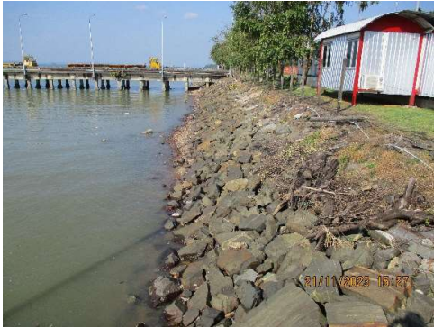
รูปที่ 2-9 แนวหินป้องกันการกัดเซาะ
