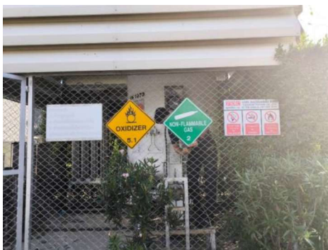
รูปที่ 2-14 การติดป้ายเตือนอันตรายบริเวณห้องเก็บก๊าซทางการแพทย์และถังออกซิเจนเหลว
