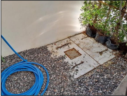
ภาพที่ 16 ท่อระบายน้ำและตะแกรงดักขยะ
