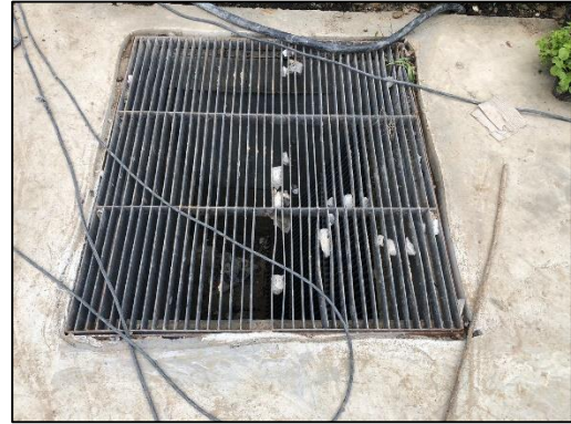
ภาพที่ 16 ท่อระบายน้ำและตะแกรงดักขยะ
