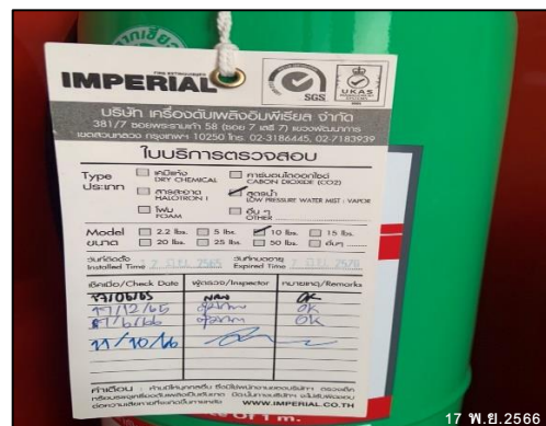
ภาพที่ 41 ตรวจเช็คถังดับเพลิง
