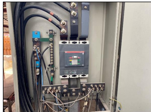
ภาพที่ 41 แผงควบคุมไฟฟ้า
