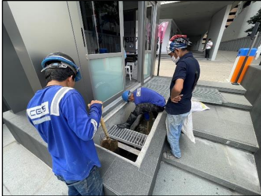
ภาพที่ 48 ขุดลอกตะกอนบริเวณบ่อพักน้ำ
