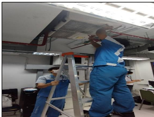
ภาพที่ 4 กิจกรรมทำความสะอาดระบบปรับอากาศ
