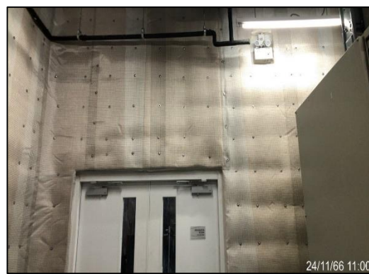
ภาพที่ 12 อุปกรณ์ป้องกันเสียงดังบริเวณห้อง Generator และ Air Cooling
