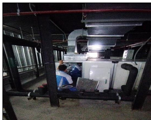
ภาพที่ 4 กิจกรรมทำความสะอาดระบบปรับอากาศ
