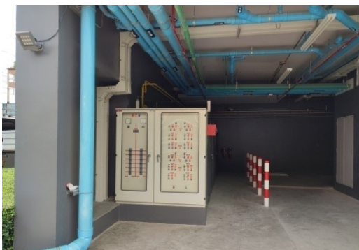
ภาพที่ 4-9 แผงควบคุมระบบบำบัดน้ำเสีย
