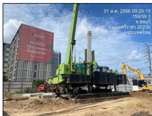
รูปที่ 29 การใช้เสาเข็มแบบเข็มกด (Jack-in Pile)
