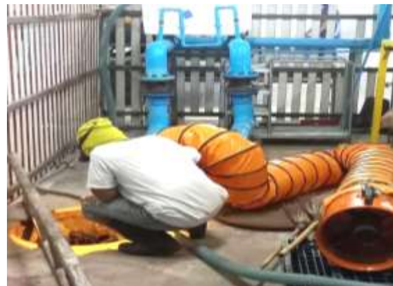
รูปที่ 2-9 การสูบตะกอนจากระบบบำบัดน้ำเสียไปกำจัด
