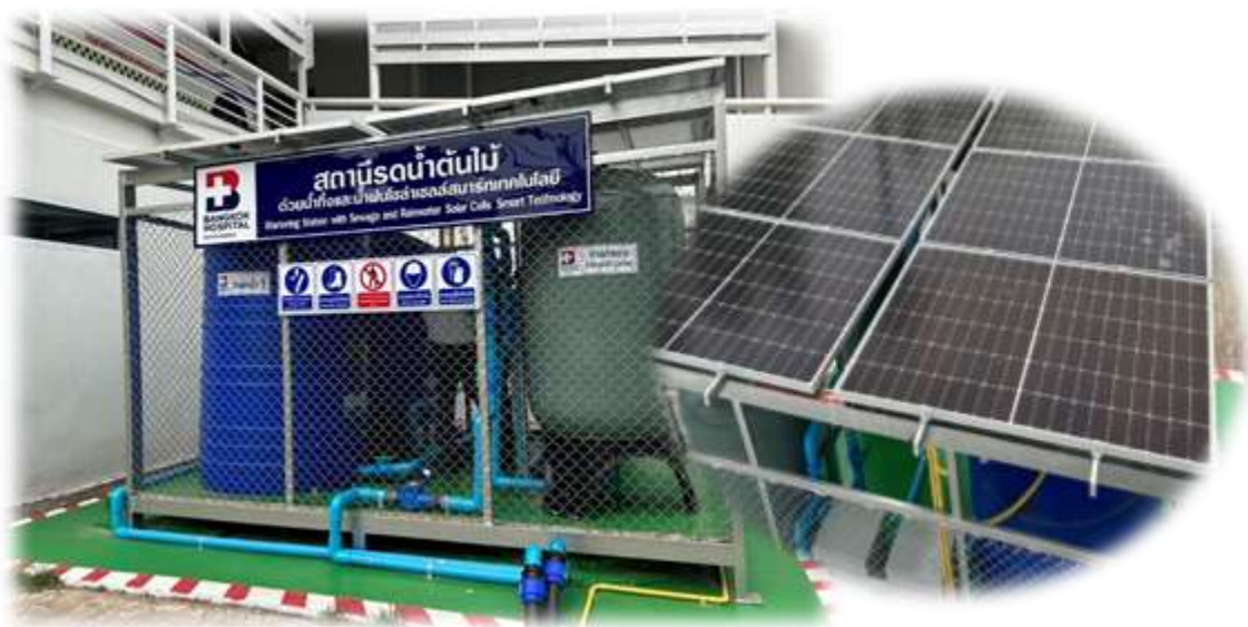
รูปที่ 2-34 การรดน้ำต้นไม้แบบระบบน้ำหยดและ โครงการรดน้ำต้นไม้อัตโนมัติด้วยน้ำทิ้งและน้ำฝน
