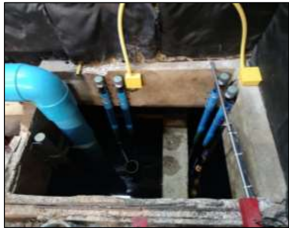
รูปที่ 2-29 ถังสำรองน้ำ และปั้มน้ำดับเพลิง
