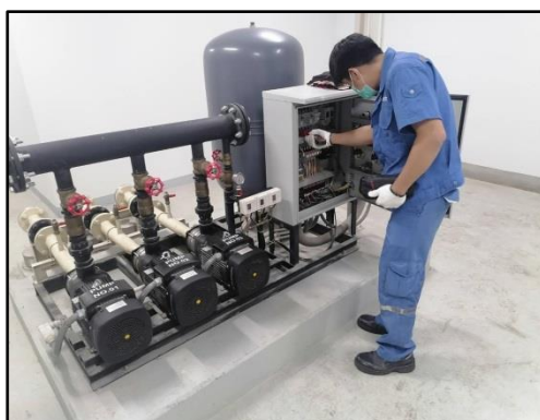
รูปที่ 32 เจ้าหน้าที่ตรวจสอบประสิทธิภาพของเครื่องสูบน้ำใช้
