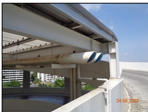
รูปที่ 23 ติดตั้งตัวกรองคาร์บอนไว้เพื่อดักจับละอองน้ำเสีย
