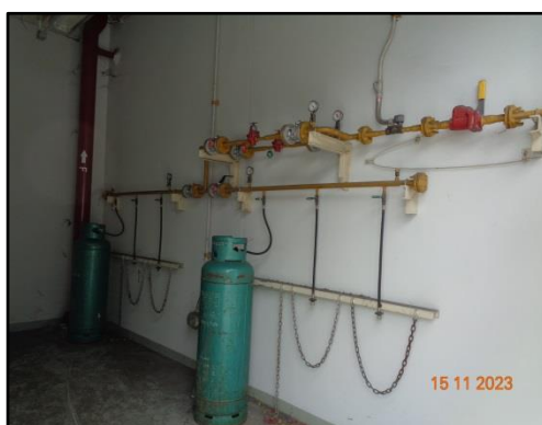
รูปที่ 18 ตำแหน่งวาล์วปิดก๊าซ สะพานไฟ สำหรับตัดกระแสไฟฟ้าที่มองเห็นได้อย่างชัดเจน
