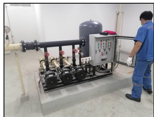
รูปที่ 32 เจ้าหน้าที่ตรวจสอบประสิทธิภาพของเครื่องสูบน้ำใช้
