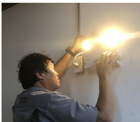
รูปที่ 3-10 การตรวจสอบสภาพความพร้อมใช้ของระบบไฟฉุกเฉินในโรงพยาบาล
