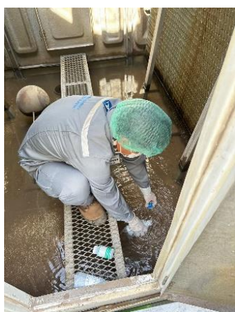
รูปที่ 3-12 การตรวจวิเคราะห์คุณภาพน้ำของระบบ Cooling Tower
