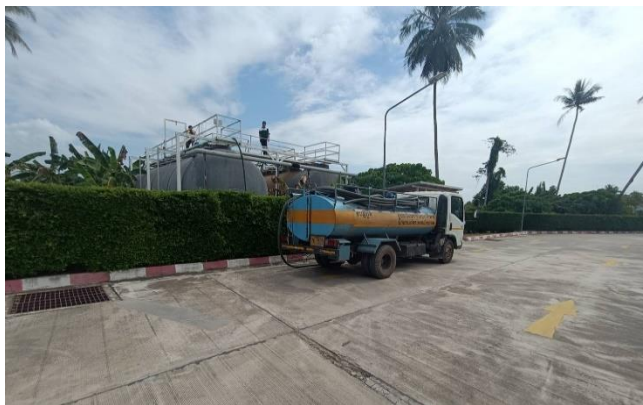
รูปที่ 2-40 การสูบน้ำจากระบบบำบัดน้ำเสียไปกำจัด
