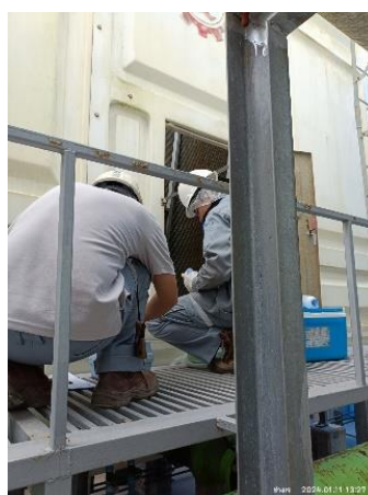
รูปที่ 3-12 การตรวจวิเคราะห์คุณภาพน้ำของระบบ Cooling Tower
