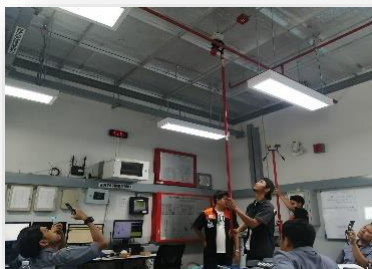
รูปที่ 3-11 การตรวจสอบสภาพความพร้อมใช้ของระบบสัญญาณแจ้งเหตุเพลิงไหม้
