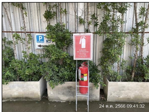
ภาพที่ 50 ถังดับเพลิงเคมี และการตรวจสอบสภาพถังดับเพลิงเคมี
