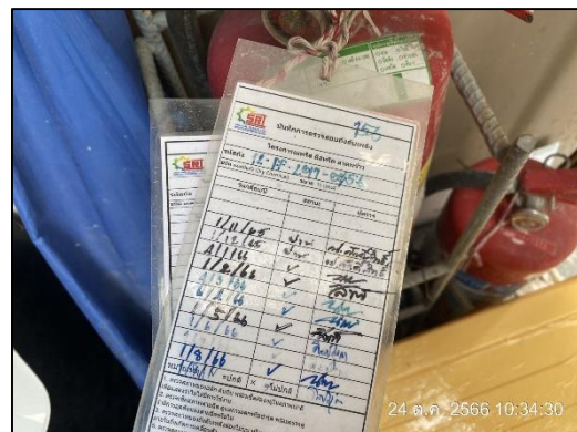
ภาพที่ 50 ถังดับเพลิงเคมี และการตรวจสอบสภาพถังดับเพลิงเคมี
