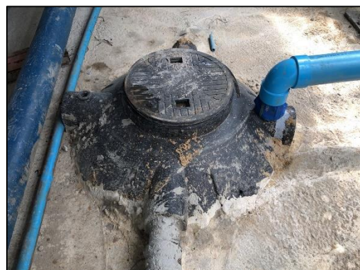
ภาพที่ 45 ถังบำบัดน้ำเสียสำเร็จรูป
