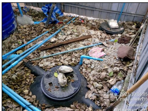
ภาพที่ 74 ถังบำบัดน้ำเสียสำเร็จรูปบริเวณบ้านพักคนงาน
