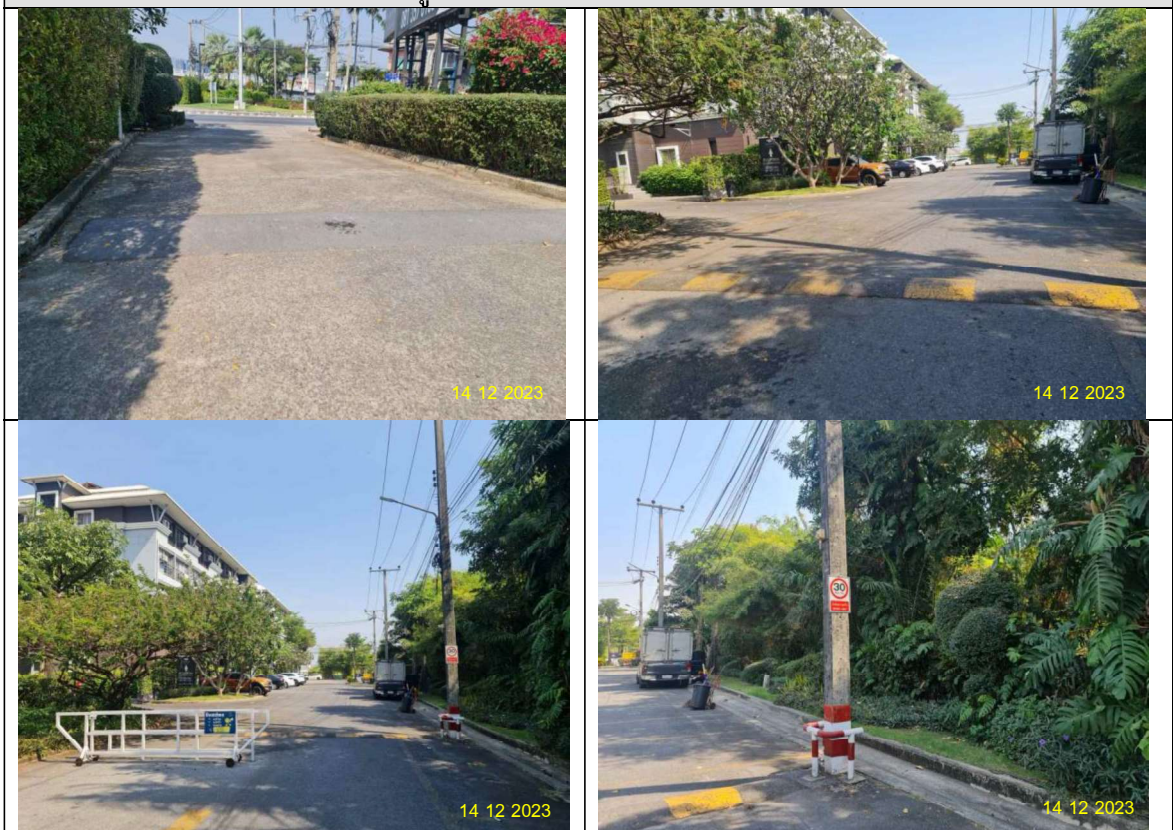
รูปที่ 2-2 การติดตั้งป้ายจำกัดความเร็ว และส่นชะลอความเร็วในพื้นที่โครงการ
