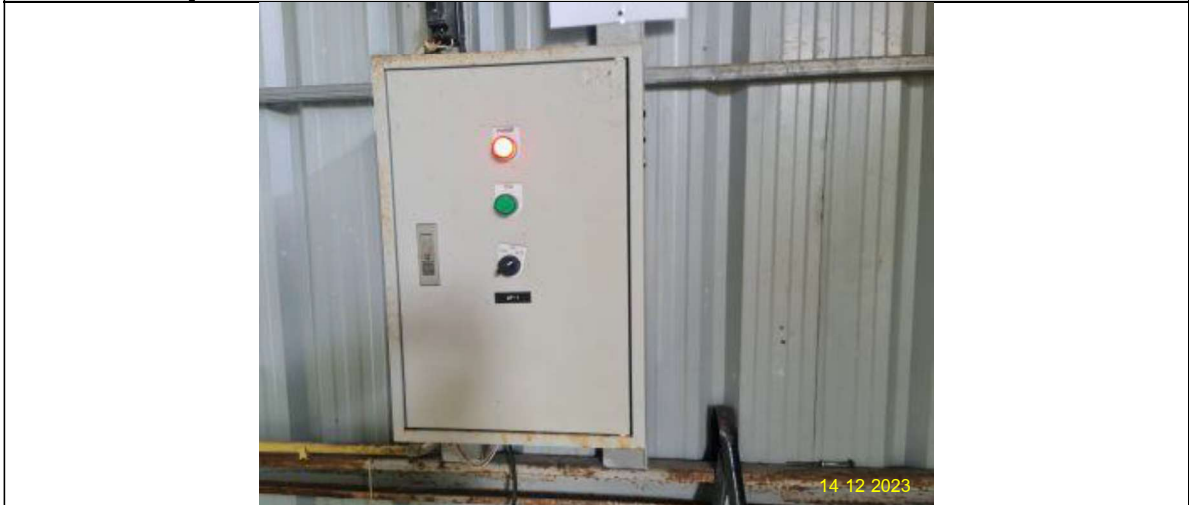
รูปที่ 2-6 การติดตั้งตู้ควบคุมไฟฟ้าระบบบำบัดน้ำเสีย
