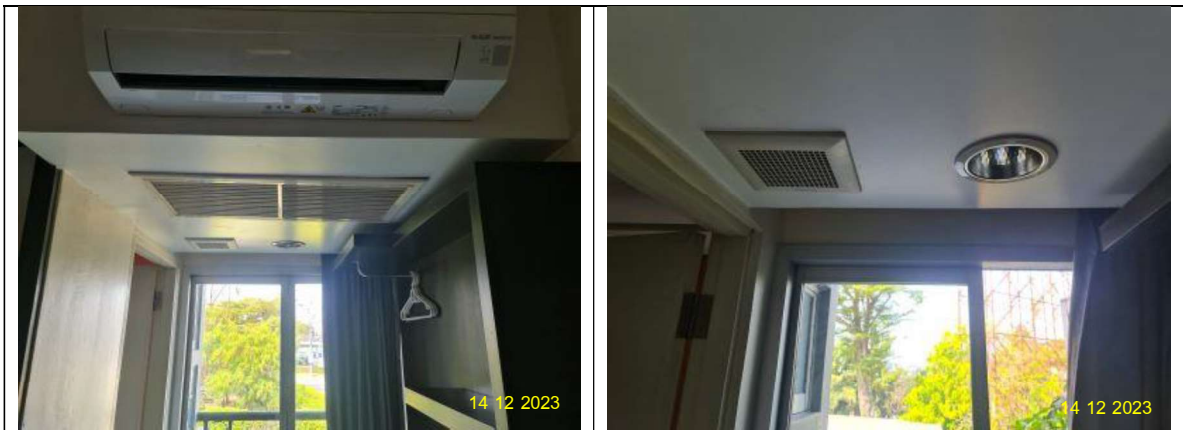
รูปที่ 2-21 การติดตั้งพัดลมระบายอากาศในห้องพักและในห้องน้ำ
