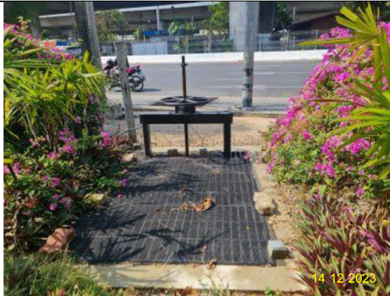
รูปที่ 2-15 การดูแลทางระบายน้ำในเขตทางหลวง และประตูระบายน้ำก่อนระบายน้ำออกจากโครงการ
