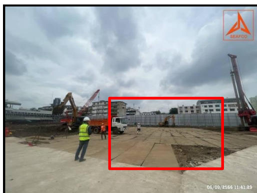
ภาพที่ 51 ปูแผ่นเหล็กบริเวณโครงการ
