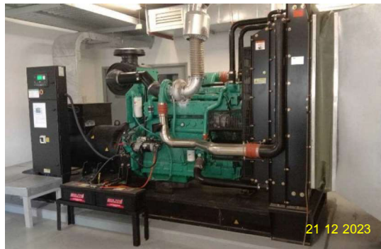
รูปที่ 2-23 การติดตั้งเครื่องกำเนิดไฟฟ้าสำรองของโครงการ
