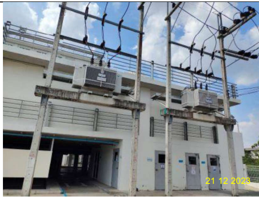
รูปที่ 2-22 การติดตั้งหม้อแปลงไฟฟ้าของโครงการ
