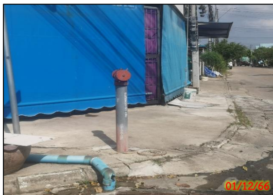
รูปที่ 2.2-3 หัวรับน้ำดับเพลิงภายในโครงการ
