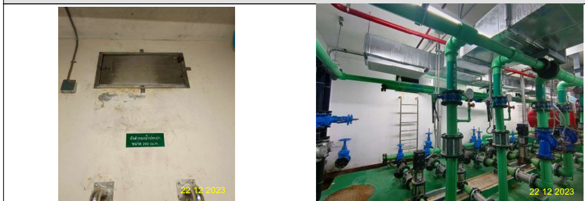
รูปที่ 2-8 ถังเก็บน้ำสำรองเพื่อการอุปโภค และน้ำสำรองดับเพลิง
