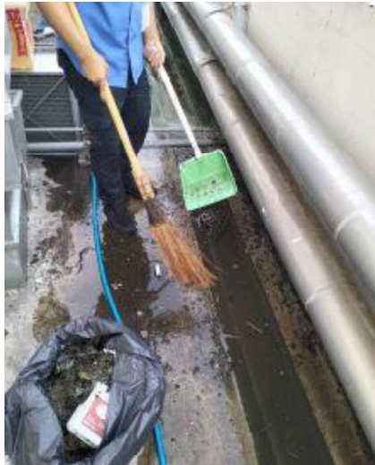
รูปที่ 2-19 การทำความสะอาด ขุดลอกท่อระบายน้ำ
