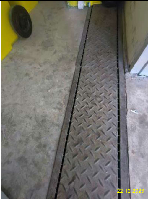
รูปที่ 2-12 รางรวบรวมน้ำเสียจากห้องพักรวมปล่อยเข้าสู่ระบบบำบัดน้ำเสีย
