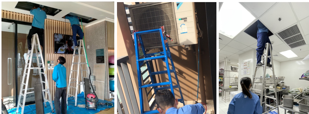
ภาพที่ 3-44 ล้างทำความสะอาดเครื่องปรับอากาศส่วนกลางประจำอาคาร
