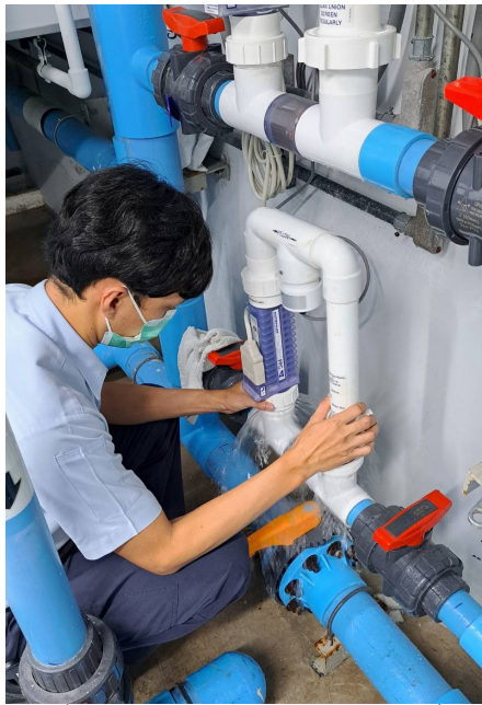
ภาพที่ 3-40 ตรวจสอบดูแลระบบประปา ไม่มีรั่วซึม
