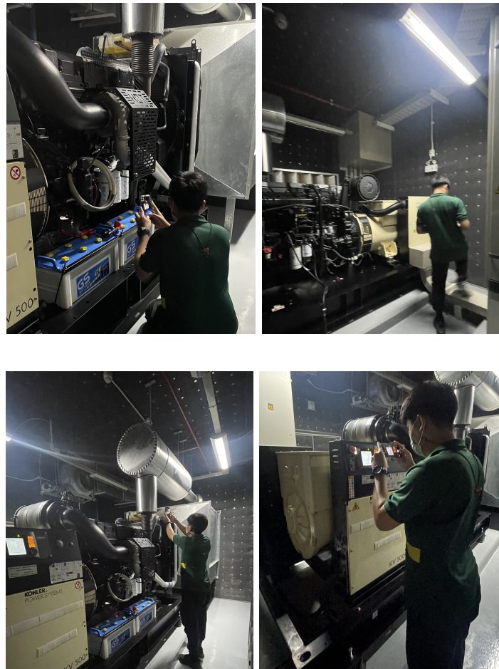
ภาพที่ 3-47 ตรวจสอบและบำรุงรักษาระบบไฟฟ้าสำรองฉุกเฉิน
