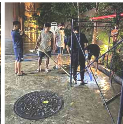
ภาพที่ 3-39 ดูดตะกอนจากระบบบำบัดน้ำเสีย และบำรุงรักษาอย่างสม่ำเสมอ
