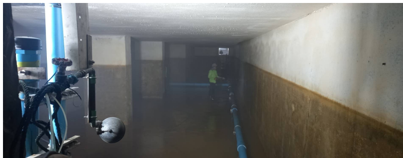
ภาพที่ 3-41 ส้างทำความสะอาดถึงสำรอน้ำใช้
