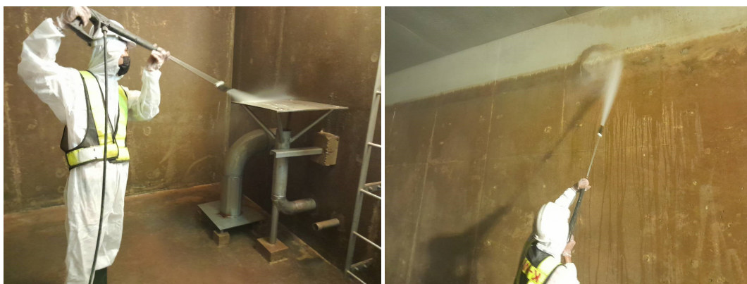
ทำความสะอาดถังสำรองน้ำใช้ที่ โรงแรมสินธร เคมปินสกี
