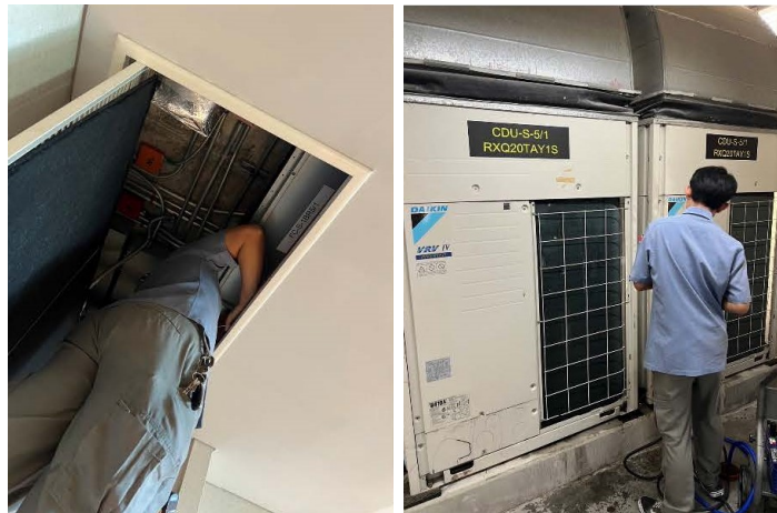
ทำความสะอาดระบบปรับอากาศที่โรงแรมคิมปีตันมาลัย ภาพที่ 4-38 ทำความสะอาดระบบปรับอากาศภายในอาคาร
