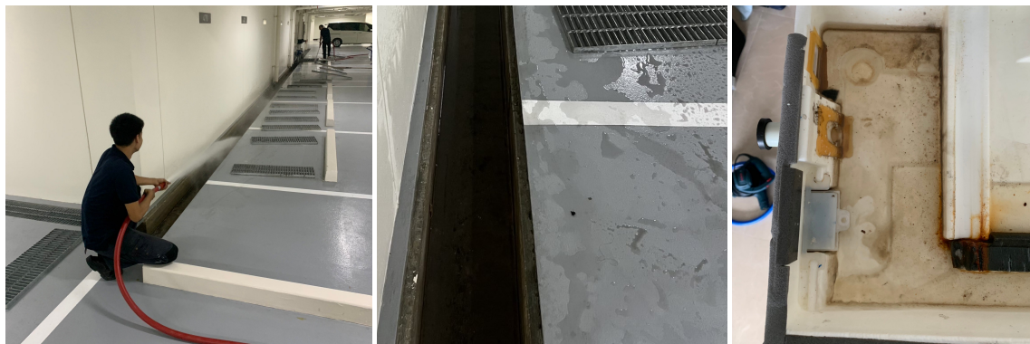
ภาพที่ 4-26 แนวท่อระบายน้ำ และรางระบายน้ำ ทำความสะอาดบ่อกักน้ำและรางระบายน้ำ
