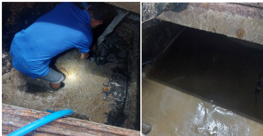
ดูดตะกอนจากบ่อพักตะกอนที่โรงแรม สิ้นธรเคมปินสกี ภาพที่ 4-39 ดูดตะกอนจากบ่อพักตะกอนของอาคาร
