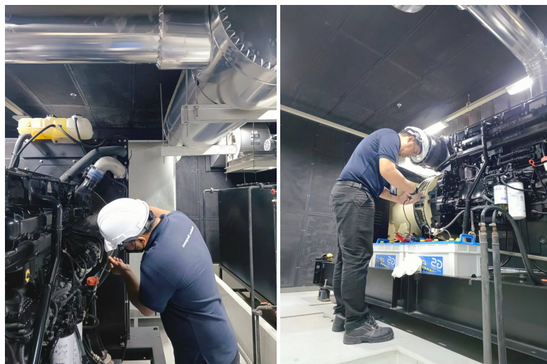
ภาพที่ 4-41 ตรวจสอบดูแลรักษาระบบเครื่องสํารองไฟฟ้าฉุกเฉิน (Generator)
