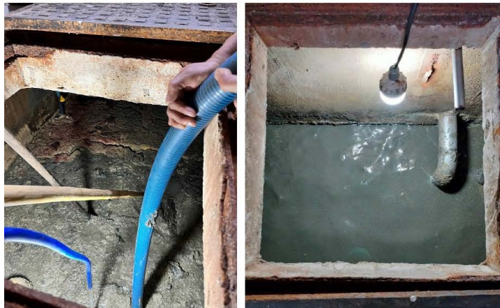
ดูดตะกอนจากบ่อพักตะกอนที่โรงแรม คิมปีตัน มาลัย
