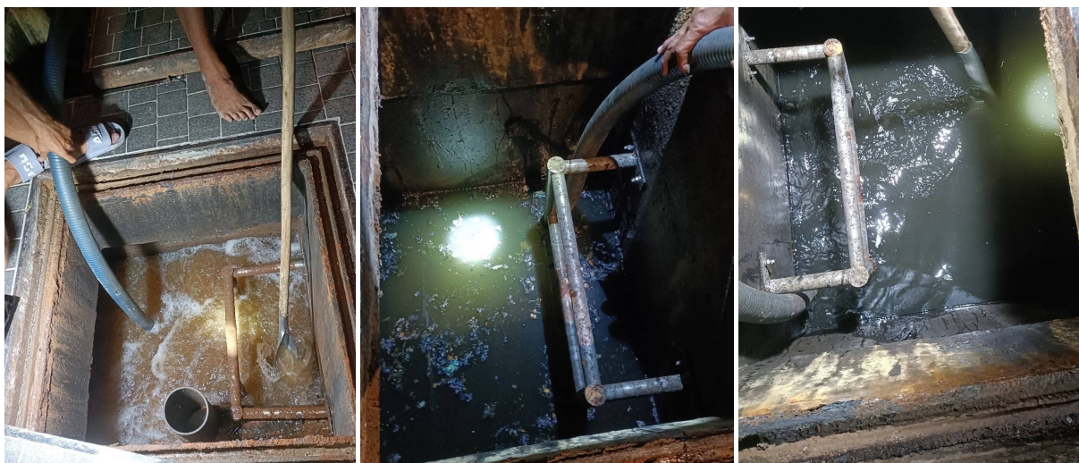
ภาพที่ 3-41 ดูแลรักษาระบบบำบัดน้ำเสีย ดูดตะกอนและดูแลรักษาระบบระบายน้ำ
