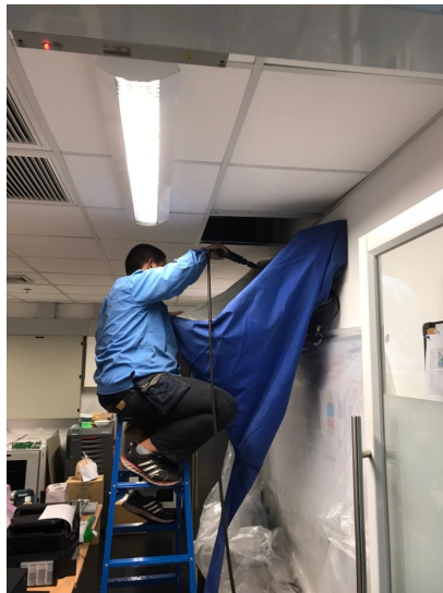
ภาพที่ 3-34 ล้างเครื่องปรับอากาศ ภายในอาคาร
