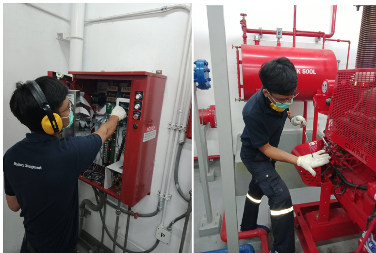
ภาพที่ 3-14 ห้องเครื่องดับเพลิง และการทดสอบประจำสัปดาห์
