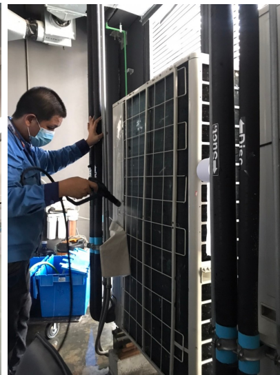
ภาพที่ 3-34 ล้างเครื่องปรับอากาศ ภายในอาคาร
