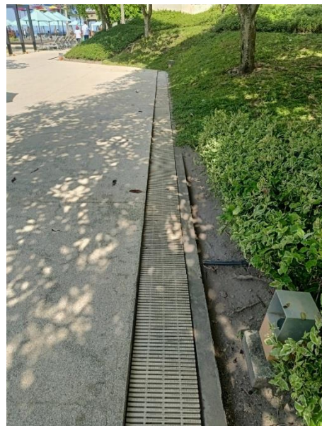
ภาพที่ 48 แสดงรางระบายน้ำรอบสระ
