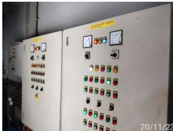
รูปที่ 1-10 ตู้ควบคุมระบบบ่อบำบัดน้ำเสีย
