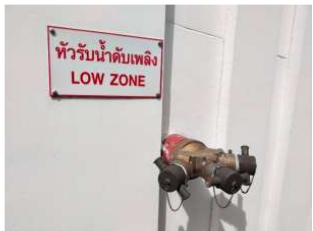
รูปที่ 1-25 หัวรับน้ำดับเพลิงภายนอกอาคารส่วน LOW ZONE
