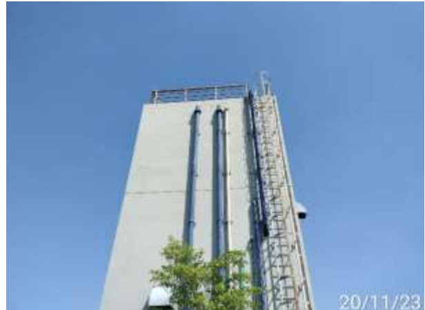
รูปที่ 1-6 ถังเก็บน้ำชั้นดาดฟ้า
