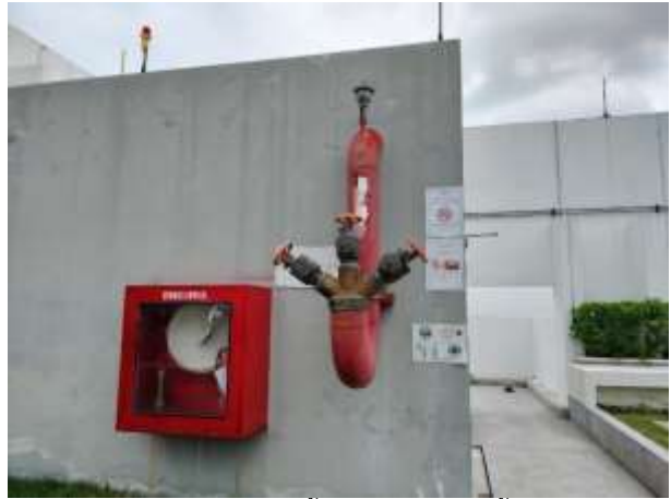
รูปที่ 1-27 ตู้หัวจ่ายน้ำดับเพลิงบริเวณชั้นดาดฟ้า
