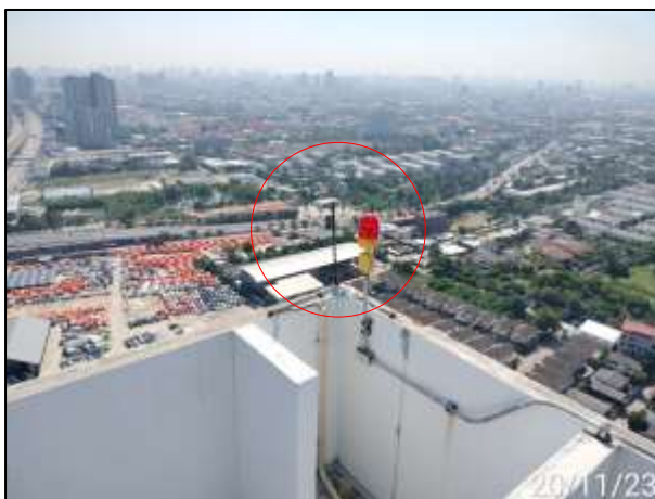
รูปที่ 1-19 แท่งตัวนำล่อฟ้า
