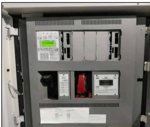
รูปที่ 2-20 แผงควบคุมระบบแจ้งเหตุอัคคีภัย (Fire Alarm Control Panel)
