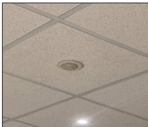
รูปที่ 2-22 เครื่องตรวจจับความร้อน (Heat Detector)
