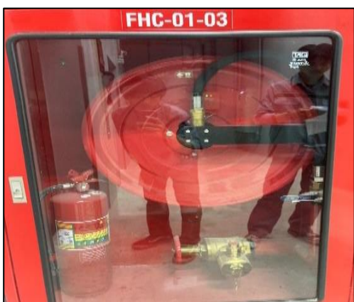
รูปที่ 2-27 ตู้เก็บสายฉีดน้ำดับเพลิง (Fire Hose Cabinet)
