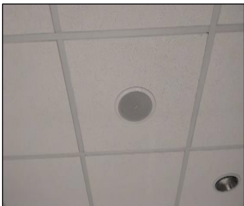
รูปที่ 2-25 ลำโพงติดเพดาน (Ceiling Speaker)
