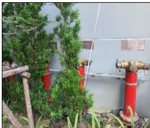
รูปที่ 2-26 หัวรับน้ำดับเพลิง (Fire Department Connection)
