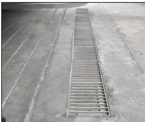
รูปที่ 2-12 รางระบายน้ำ และตะแกรงดักขยะ
