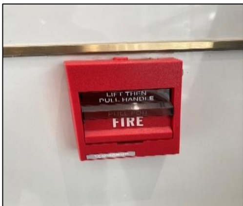
รูปที่ 2-23 อุปกรณ์แจ้งเหตุด้วยมือ (Manual Pull Station)
