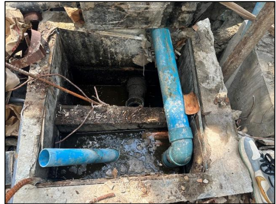
รูปที่ 2-13 บ่อพักน้ำเสียก่อนระบายออกสู่ ท่อระบายน้ำสาธารณะ
